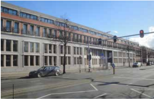
Foto 1: School op een verkeersbelaste locatie. De lokalen aan de straatzijde zijn voorzien van mechanische luchttoevoer, waardoor lucht gefilterd kan worden. De buitenlucht wordt aangezogen aan de verkeersluwe achterzijde van het gebouw. Ramen aan de straatzijde kunnen niet worden geopend.
